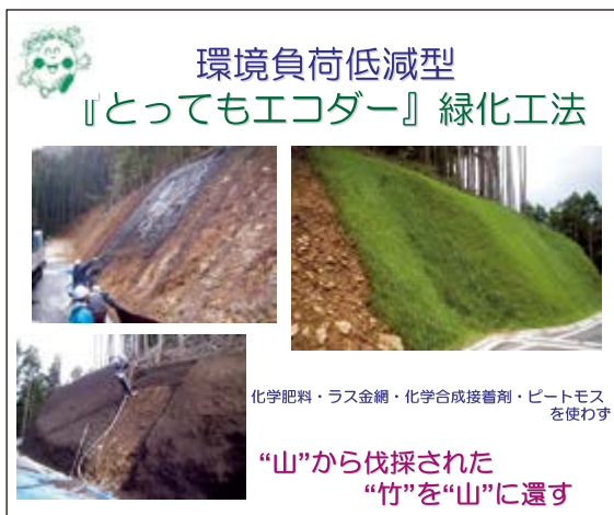
図2 『とってもエコダー』を使用した法面施工例
