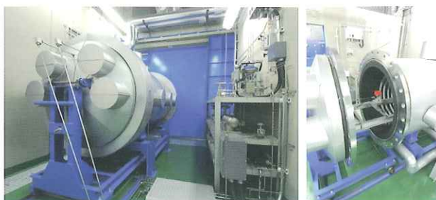
高圧水素試験室(右:耐爆力バー開扉時)
