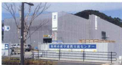
福岡市産学連携交流センター（建設中）
