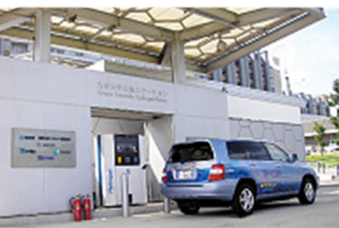
水素ステーション(九州大学キャンパス内実証実験施設)
