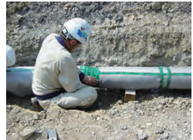
写真：防護材施行風景
