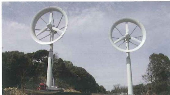
図1. 100kW風レンズ風車(九大伊都キャンパス、ロータ径13m)
